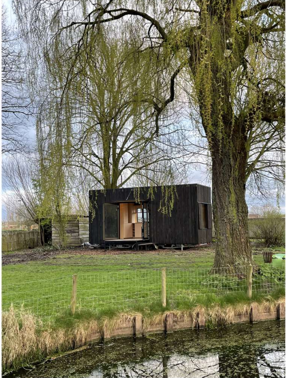
Réalisation d'une tiny house
